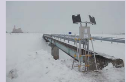
現場実証実験第二弾※寒冷地仕様(最上川水系)
