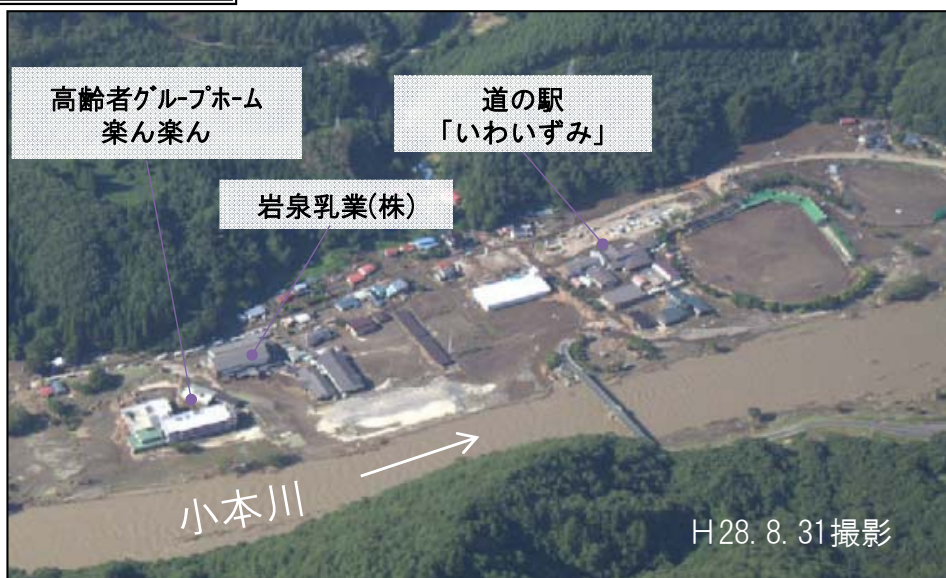
平成28年8月台風10号による小本川被災状況(岩手県岩泉町)
