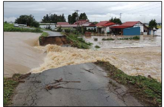
平成27年9月洪水で破堤した二迫川（栗原市）
