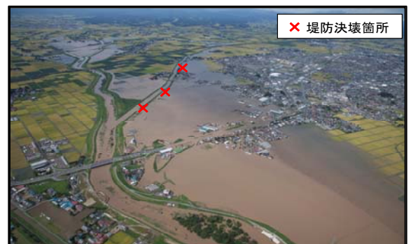
平成27年9月関東・東北豪雨で 3箇所堤防が決壊した洪井川
