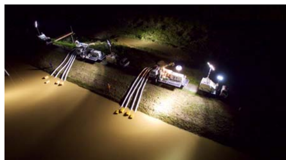
二迫川排水状況 (H27.9洪水)
