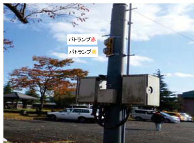
簡易アラート設置状況（H28.11.2）
