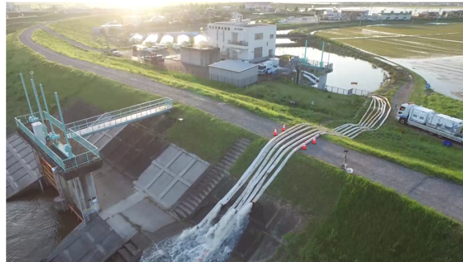
大崎市古川米袋付近における排水ポンプ稼働状況 (多田川左岸2.6k付近)
