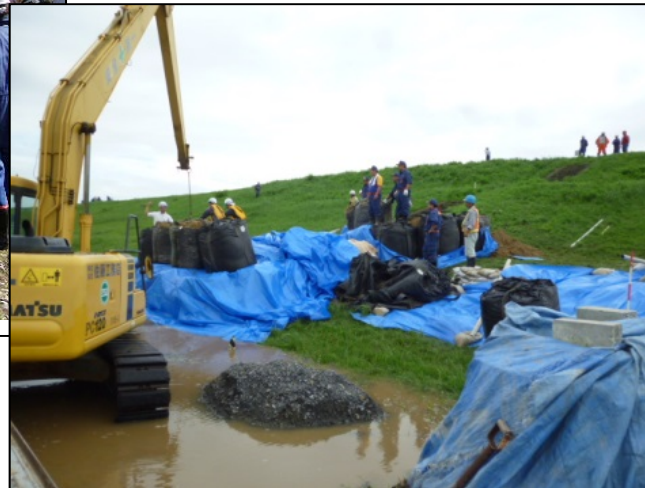
建設業者の重機を活用した月の輸工による漏水対策を実施 (大崎市鹿島台大迫上志田地内)
