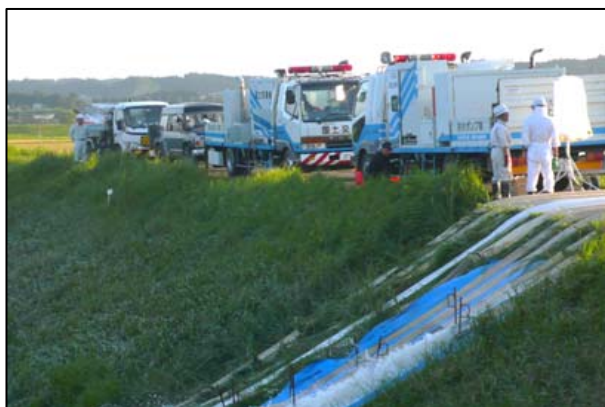
排水ポンプ車による排水作業
