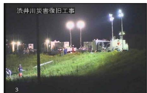
照明車設置による24時間復旧工事
