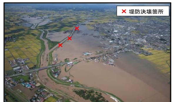
平成27年9月関東・東北豪雨で3箇所堤防が決壊した洪井川
