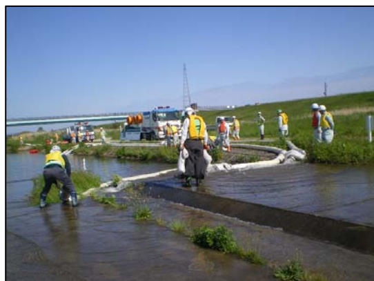
排水ポンプ車設置訓練状況
