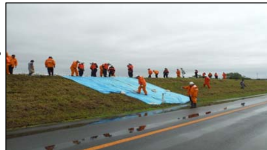
江合川での水防活動（シート張工）
