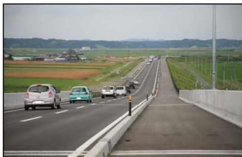
二線堤整備状況
