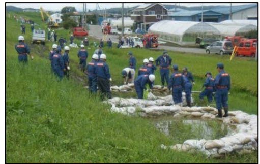
吉田川での水防活動（月の輪工）
