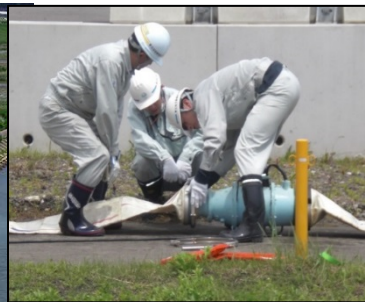
排水ポンプ車の設置訓練と排水ポンプ始動訓練
