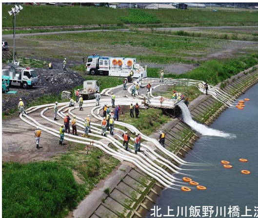
排水ポンプの設置排水訓練
