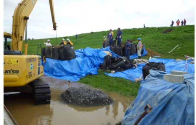
建設業者の重機を活用した月の輪工による漏水対策を実施
