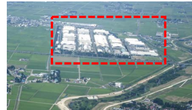
YKK AP(株)東北事業所と大崎市が災害時における燃料等の供給協力に関する協定の締結
