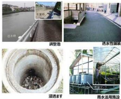
雨水貯留浸透施設の例
