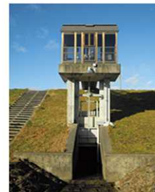
北上川：狐穴排水樋管
