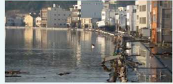
被災直後(旧北上川右岸中央地区)
