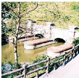
洪水防御のため明治潜穴を開削(1910年) 土木学会選奨土木遺産(品井沼干拓関連施設)
