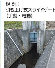
鳴瀬川：竹下江排水樋管
