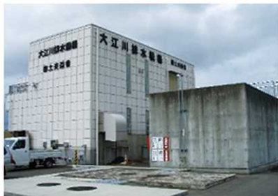
大江川排水機場（大崎市）
