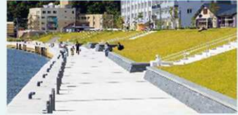
整備後(旧北上川右岸中央地区)
