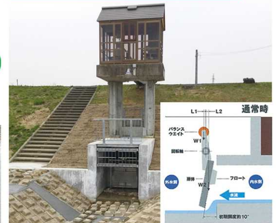
北上川：狐穴排水樋管
