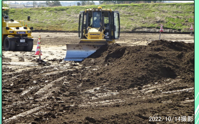
奥田川排水樋門 河川土工（置換盛土） 施工中
