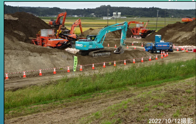
桧和田ヤード 土質改良工(土質改良) 施工中
