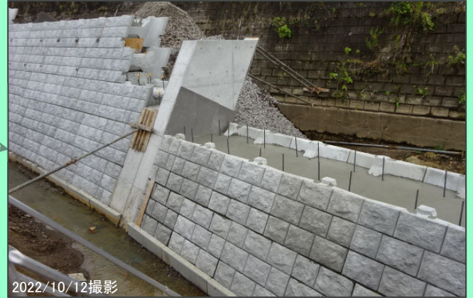
落合舞野地区 法覆護岸工 (大型ブロック設置) 施工中
