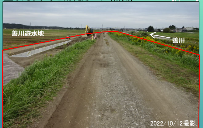
全景写真（越流堤部：起点側）
