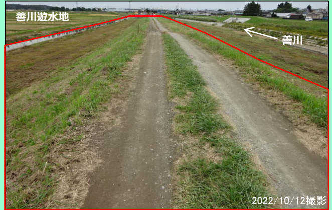
全景写真（越流堤部：起点側）
