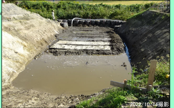
奥田川排水樋門 河川土工（置換盛土） 施工中
