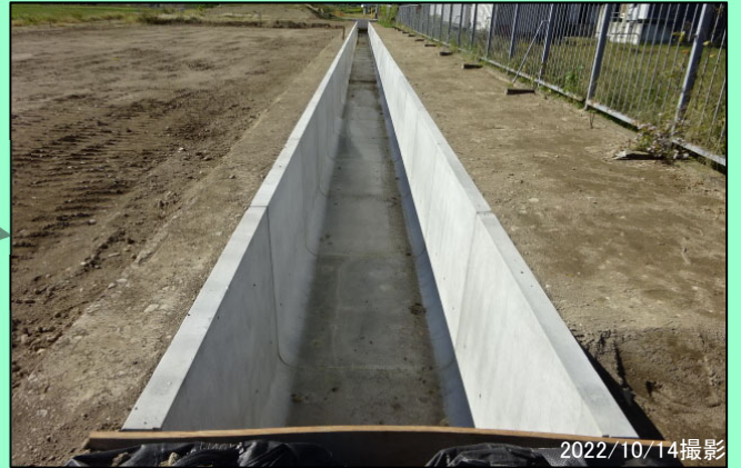
奥田川排水樋門 地盤改良工（中層混合処理） 施工中
