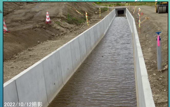
管理用道路 水路工 (大型水路、集水枡、函渠) 完了
