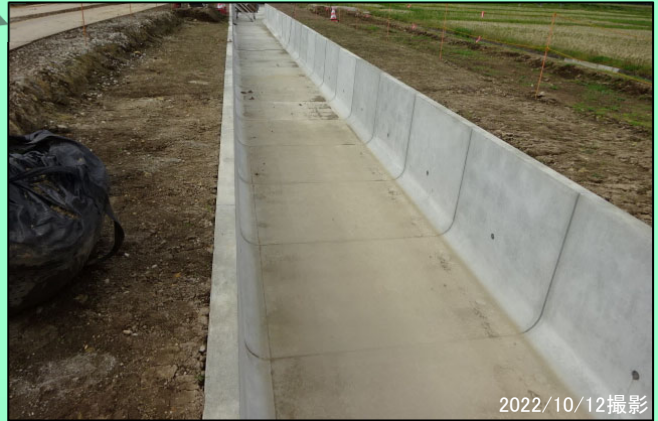
囲繞堤部：終点側 側溝工(埋戻し) 施工中
