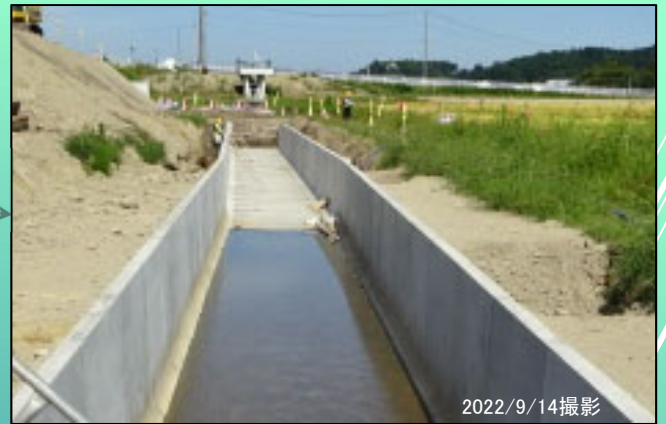
管理用道路 側溝工 施工中
