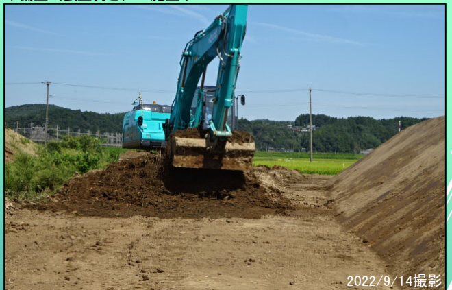
桧和田ヤード 準備工（表土剥ぎ） 施工中
