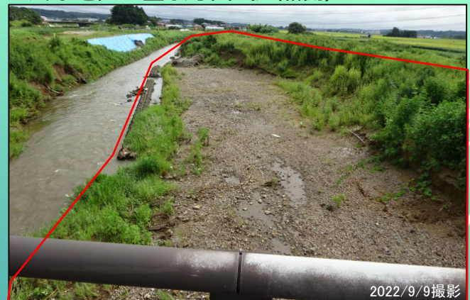
上川原地区 全景写真（起点側）
