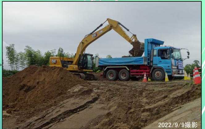
桧木川原地区 河川土工（河道掘削） 施工中
