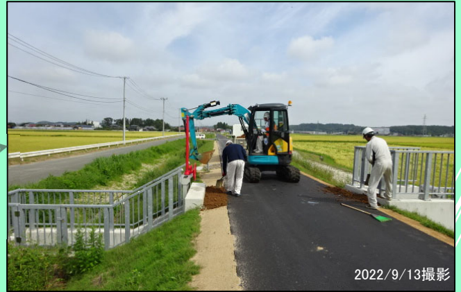
新舞野地区 付帯道路工（路肩盛土） 施工中
