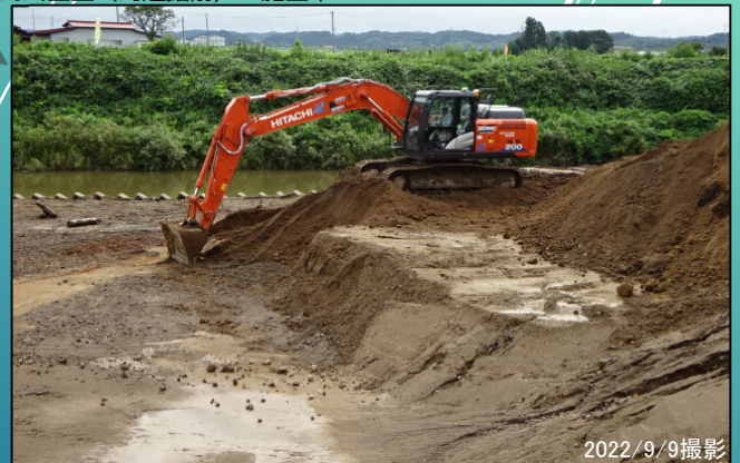
桧木川原地区 河川土工（河道掘削） 施工中
