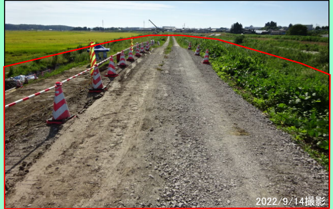
全景写真（越流堤部：起点側）
