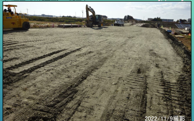
奥田川排水樋門 河川土工（築堤盛土） 施工中
