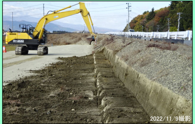
周囲堤部 河川土工（築堤盛土） 施工中
