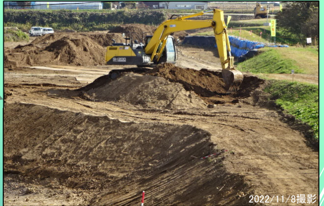
上川原地区 準備工（表土剥ぎ搬出） 施工中
