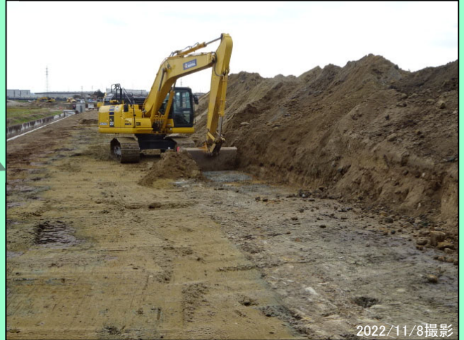
越流堤部 河川土工（掘削） 施工中
