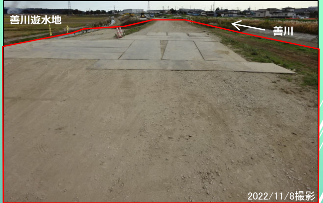
全景写真（越流堤部：起点側）
