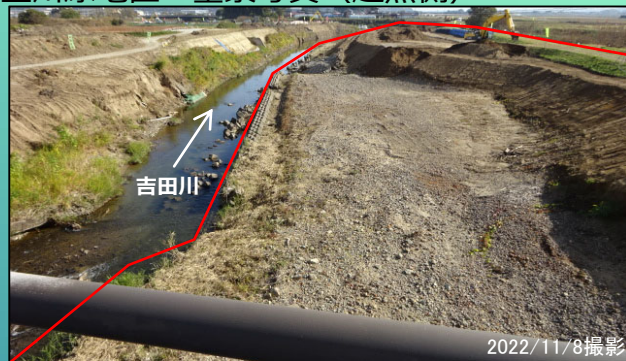
上川原地区 全景写真（起点側）
