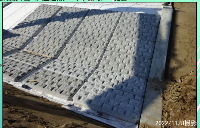
桧木川原地区 法覆護岸工(吸出し防止材敷設) 施工中
