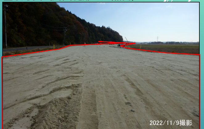
全景写真（周囲堤部：起点側）
