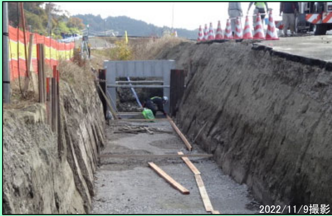
周囲堤部 水路工（基礎コンクリート打設） 施工中
