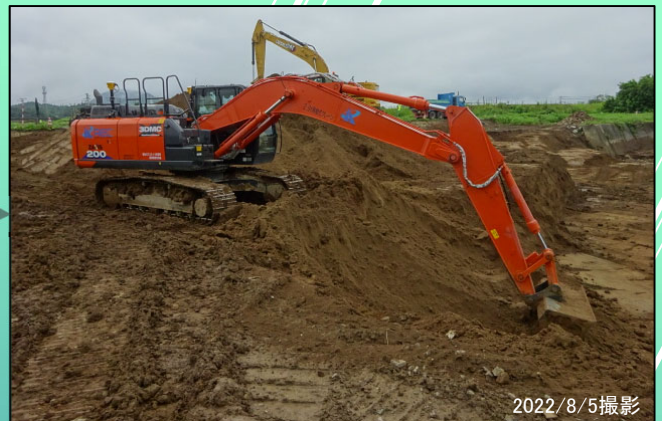
桧木川原地区 構造物撤去工 (既設護岸撤去) 施工中
