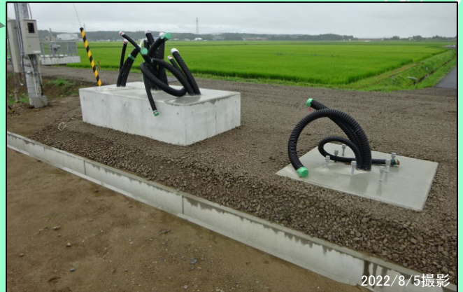
新舞野地区 情報管路工 (機器設備基礎) 完了
