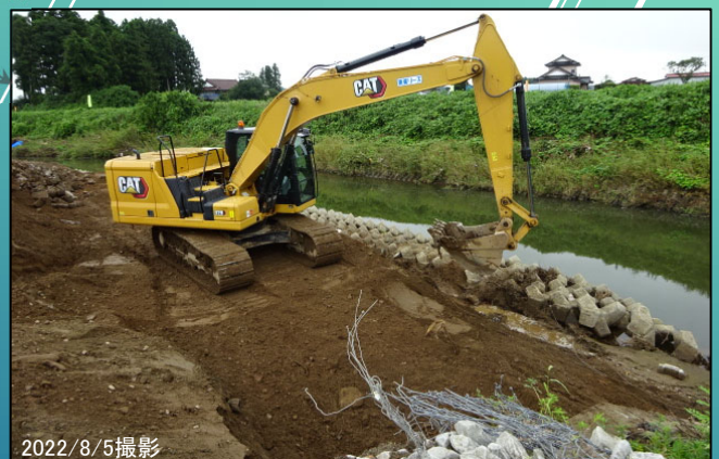
桧木川原地区 構造物撤去工 (既設護岸撤去) 施工中
