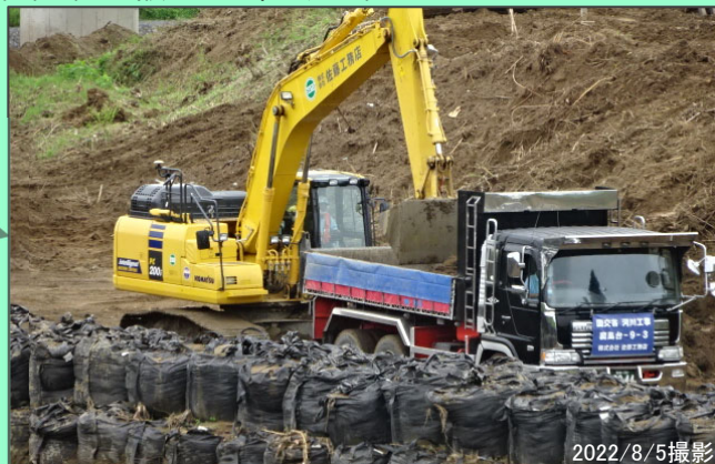
落合舞野地区 河川土工 (表土剥ぎ) 施工中
