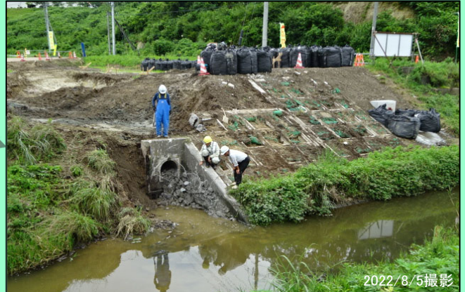
奥田川排水樋門 仮設工（大型土のう製作、仮置き） 施工中
