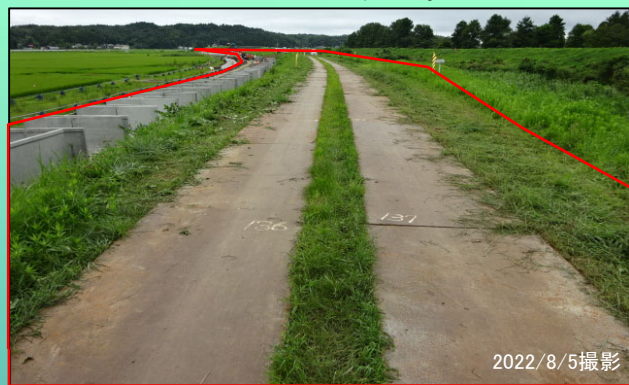
囲繞堤部：起点側 側溝工（埋戻し） 施工中
