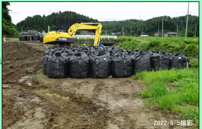
奥田川排水樋門 仮設工（大型土のう製作、仮置き） 施工中
