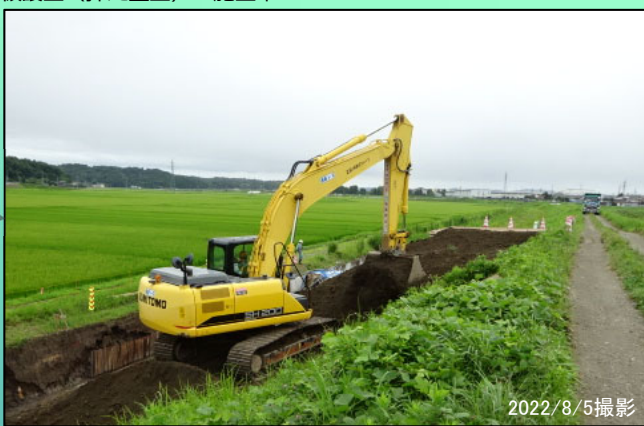
管理用道路 仮設工 (押え盛土) 施工中
