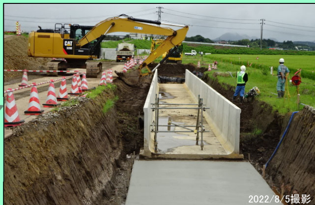
囲繞堤部：起点側 側溝工（埋戻し） 施工中
