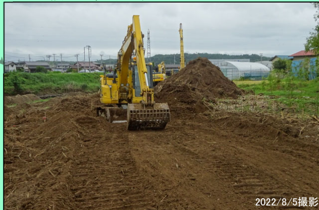
落合舞野地区 河川土工 (表土剥ぎ) 施工中
