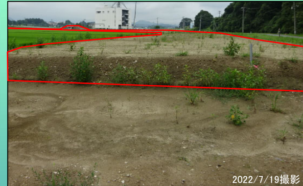
全景写真（NTT大衡交換所側：終点側）
