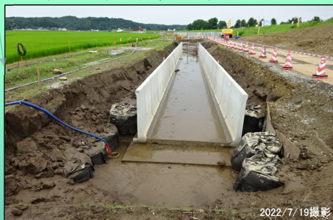
囲繞堤部 側溝工（大型水路据付、埋戻し） 施工中
