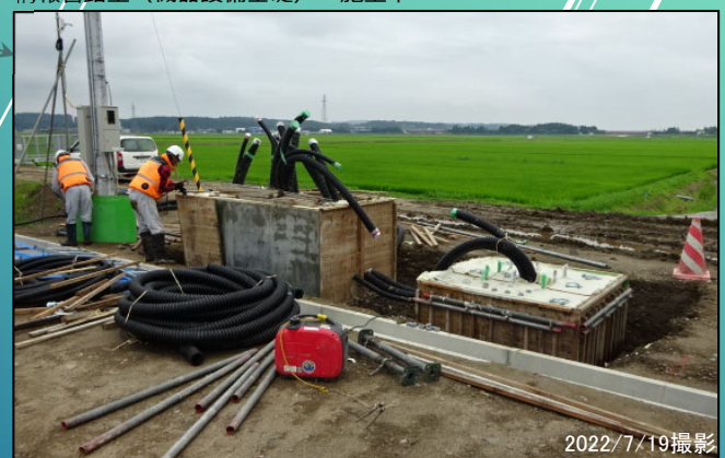
新舞野地区 情報管路工（機器設備基礎） 施工中
