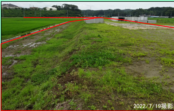
全景写真（奥田川排水樋門側：起点側）
