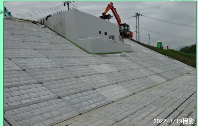
新舞野地区 越流堤本体工（コンクリート打設） 完了
