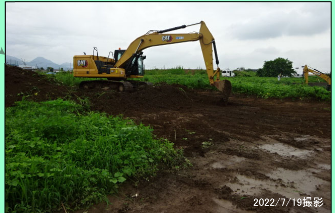
桧木川原地区 準備工 (表土剥ぎ) 施工中
