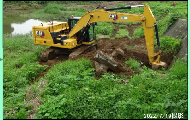
桧木川原地区 準備工 (表土剥ぎ) 施工中
