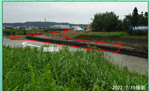
落合舞野地区 仮設工 (大型土のう設置) 完了
