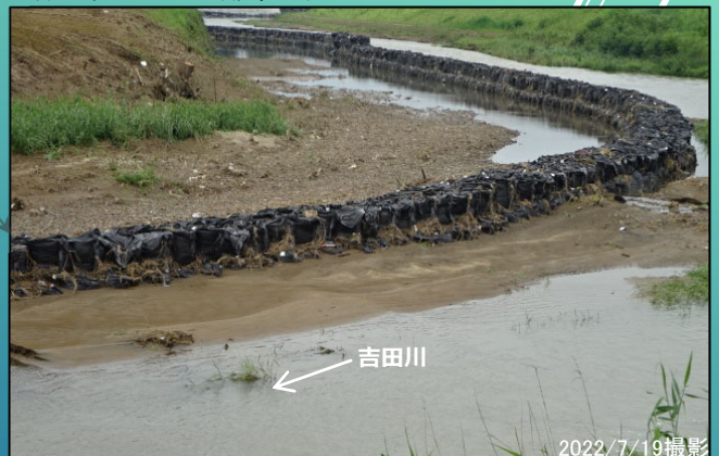
落合舞野地区 仮設工 (大型土のう設置) 完了
