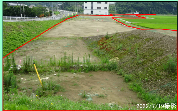
全景写真（NTT大衡交換所側：起点側）
