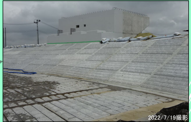
下草橋（右岸側） 橋台工、法覆護岸工 完了
