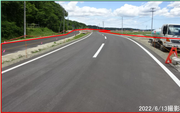
全景写真（起点側）
