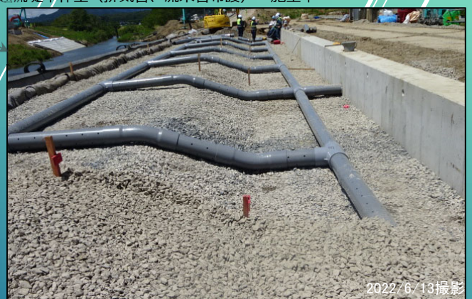
新舞野地区 越流堤本体工（排気管、流末管布設） 施工中
