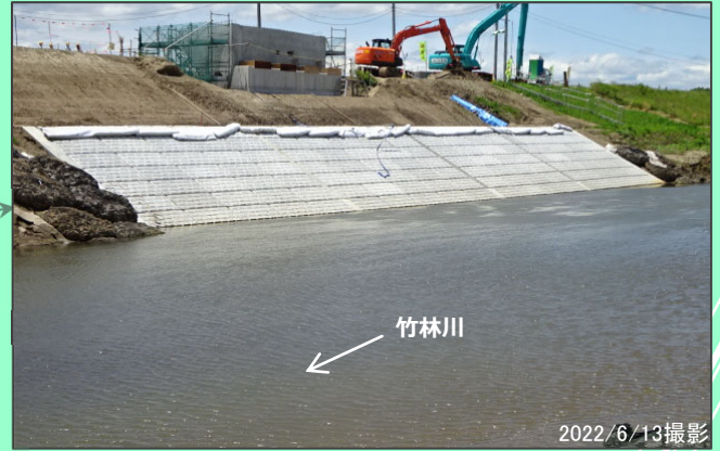
下草橋（左岸側） 橋台工（モルタルペースト塗布） 施工中
