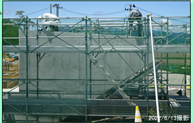
新舞野地区 越流堤本体工（コンクリート打設） 施工中
