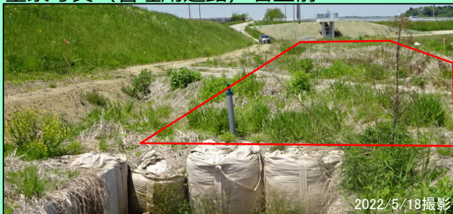
全景写真（管理用道路）着工前
