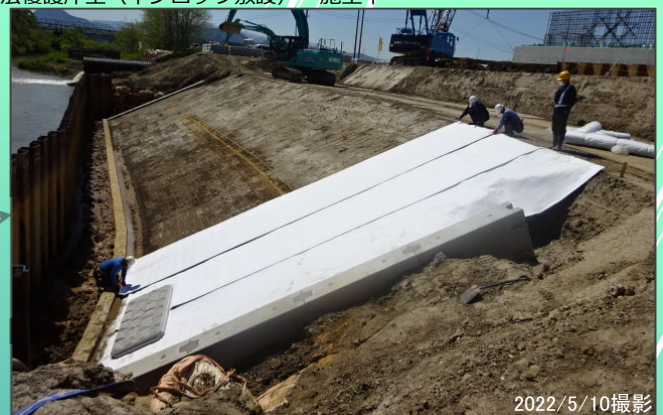
下草橋（右岸側） 橋台工（型枠設置） 施工中
