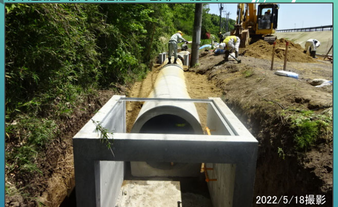
周囲堤部 付帯道路工（排水構造物工：埋戻） 施工中
