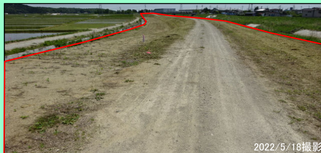
全景写真（囲繞堤部：終点側）着工前
