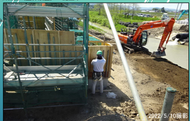
下草橋（右岸側） 橋台工（型枠設置） 施工中
