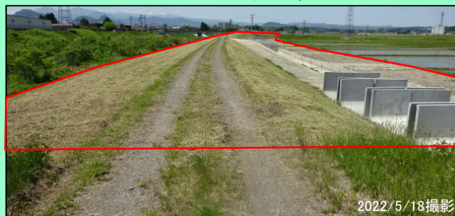
全景写真（囲繞堤部：起点側）着工前
