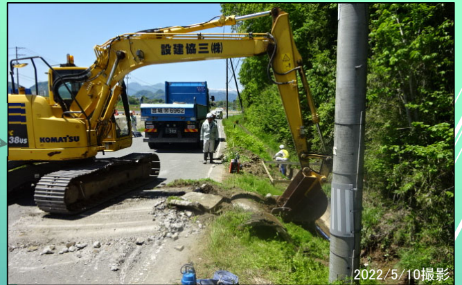
周囲堤部 付帯道路工（排水構造物工：埋戻） 施工中
