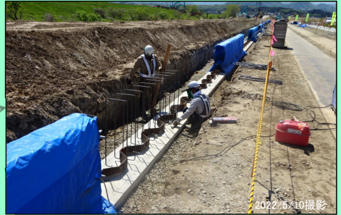
新舞野地区 基礎工（型枠設置） 施工中
