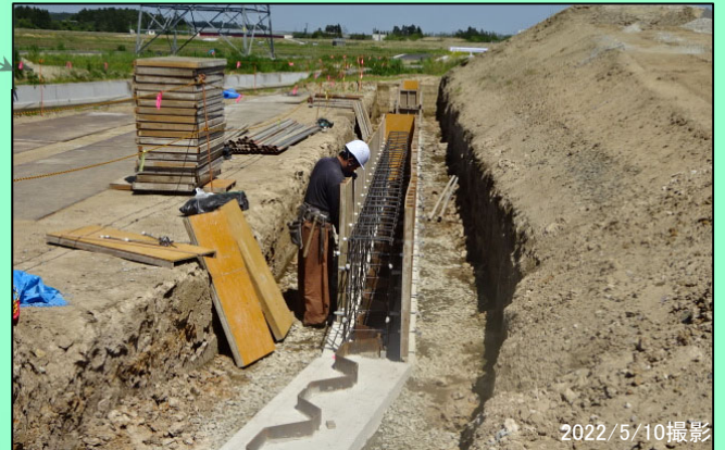
新舞野地区 基礎工（型枠設置） 施工中
