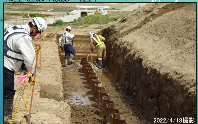
新舞野地区 基礎工（基礎碎石敷設） 施工中
