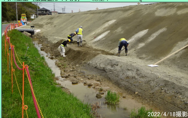
周囲堤部 河川土工（法面整形：人力） 施工中
