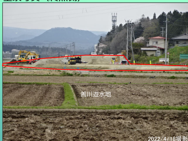
全景写真（終点側）
