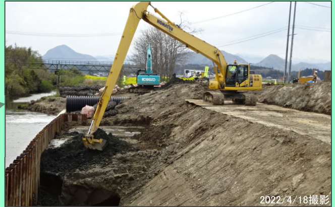
下草橋（右岸側） 法覆護岸工（法面整形） 施工中
