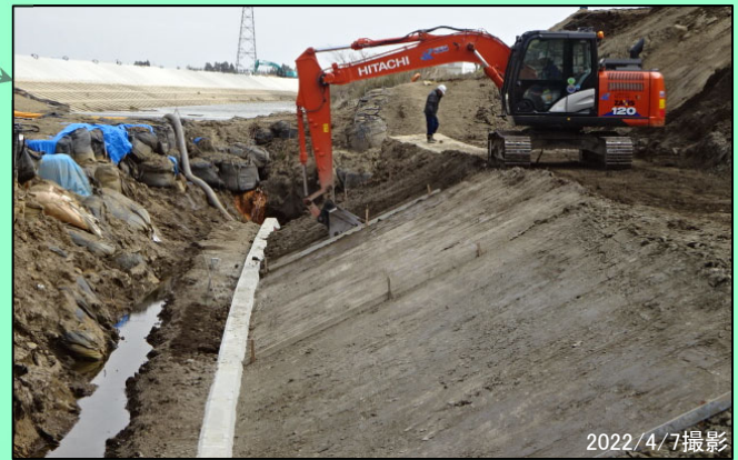
下草橋（右岸側） 法覆護岸工（法面整形） 施工中
