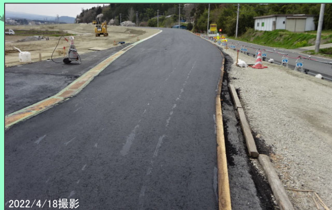
周囲堤部 アスファルト舗装工（表層） 施工中
