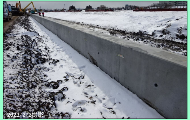
越流堤部（川表） 護床工（護床ブロック据付） 完了
