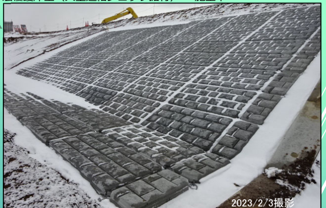
上川原地区 法覆護岸工（大型連結ブロック据付） 施工中
