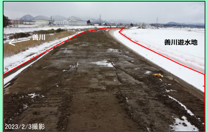
囲繞堤部 河川土工（高上げ盛土） 施工中
