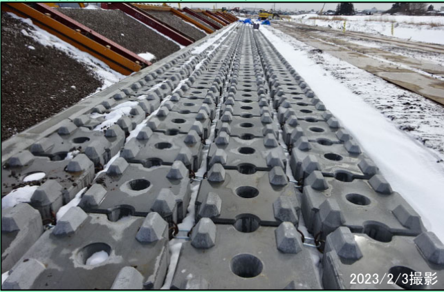
①越流堤部（川表） 護床工（護床ブロック据付） 施工中
