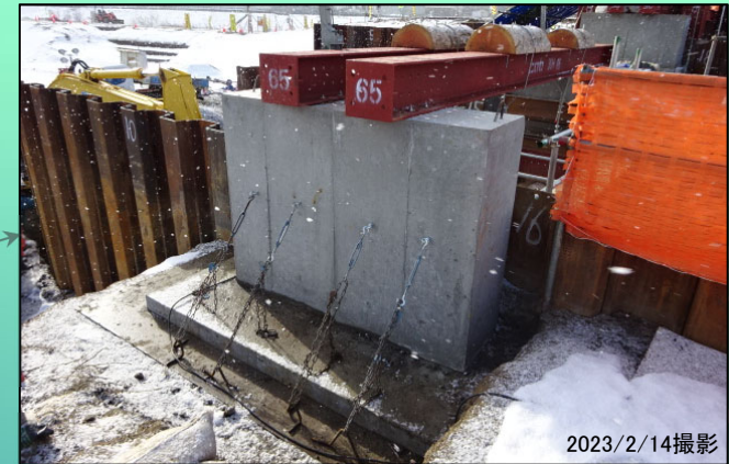
圍繞堤部 横断工 (1次掘削) 施工中
