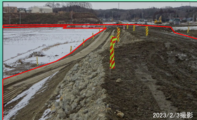
全景写真（奥田川排水樋門側：起点側）
