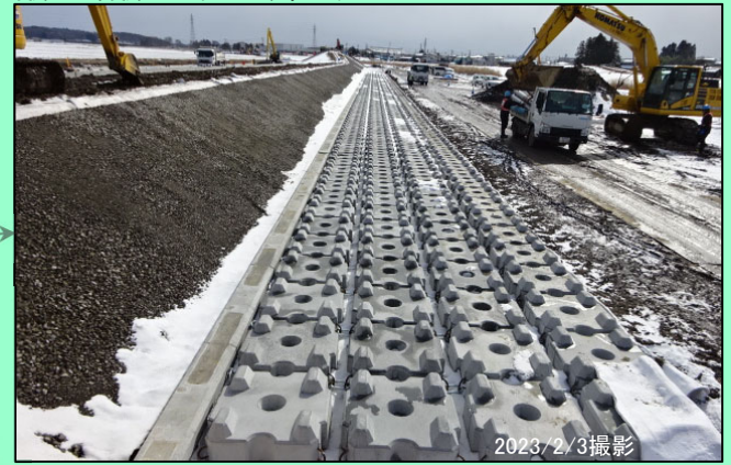
越流堤部（川裏） 越流堤本体工（V P管敷設） 施工中
