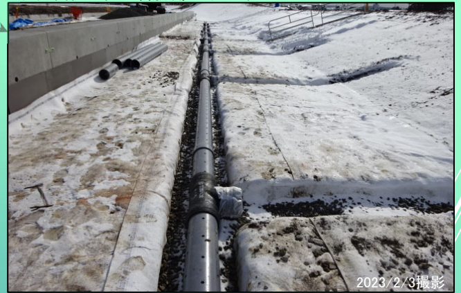
越流堤部（川裏） 越流堤本体工（V P管敷設） 施工中
