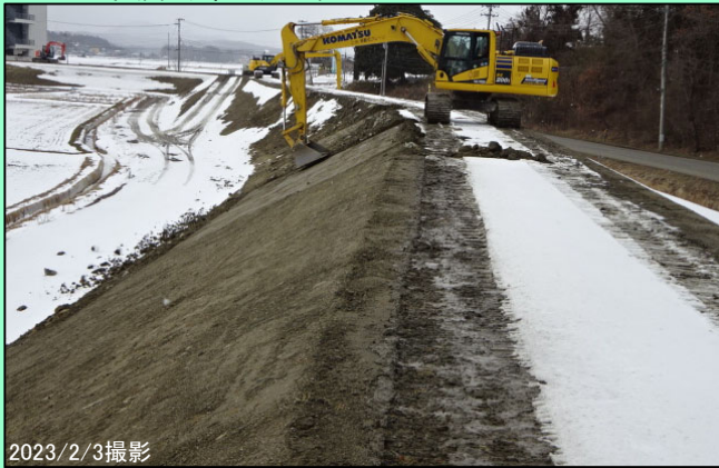
① 周囲堤部 河川土工（法面整形） 施工中
