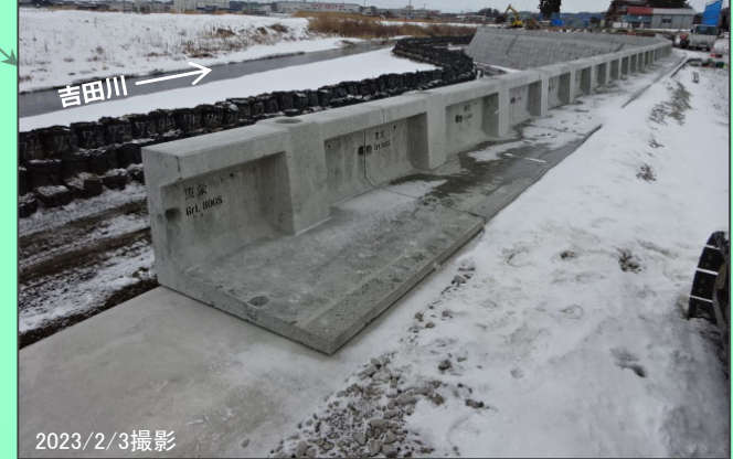
落合舞野地区 プレキャスト擁壁工 (L型擁壁) 施工中
