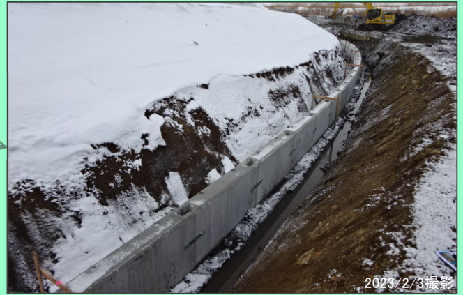
落合舞野地区 プレキャスト擁壁工 (L型擁壁) 施工中
