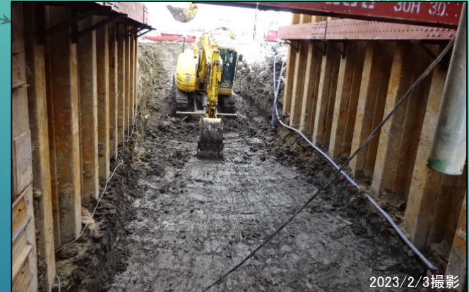
圍繞堤部 横断工 (1次掘削) 施工中
