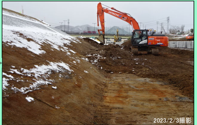
上川原地区 法覆護岸工（大型連結ブロック据付） 施工中
