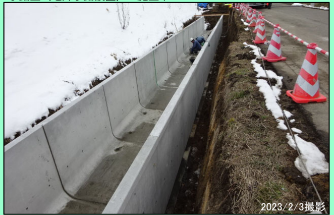
② 周囲堤部 水路工（地外水路設置） 施工中
