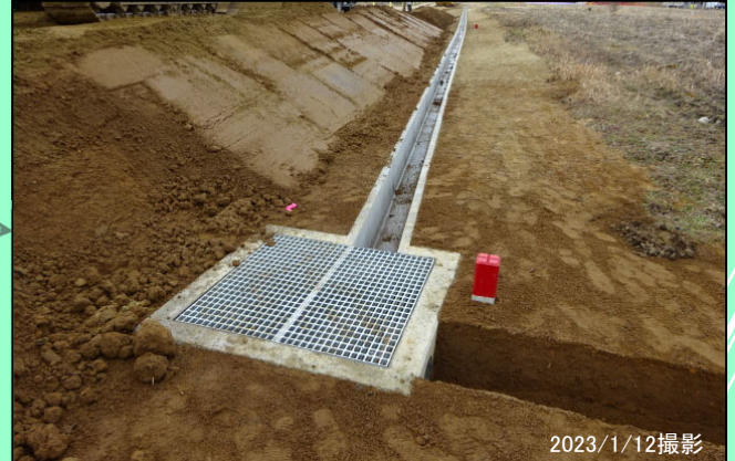
南岡江地区 河川土工（路体盛土、法面整形） 施工中
