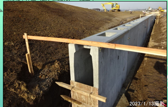
越流堤部（川裏） 越流堤本体工（副ダム据付） 施工中
