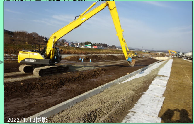
越流堤部（川裏） 越流堤本体工（副ダム据付） 施工中
