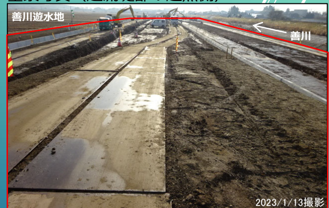
全景写真（越流堤部：起点側）
