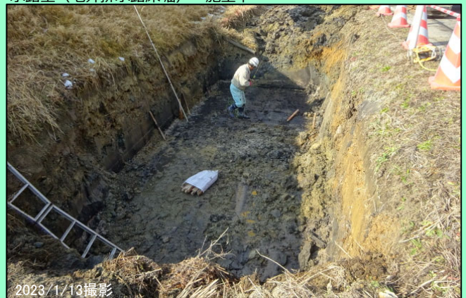
② 周囲堤部 水路工（地外排水路床掘） 施工中
