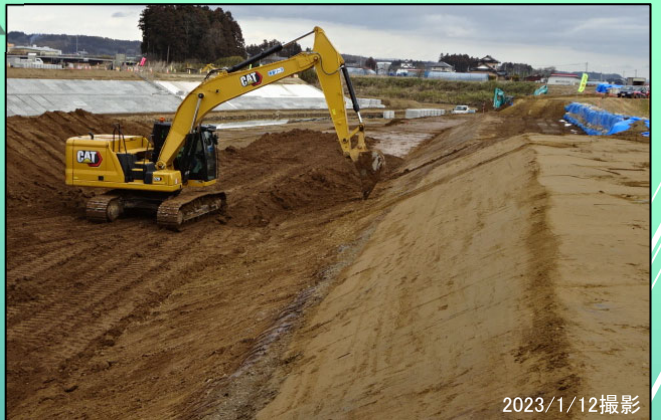
上川原地区 河川土工（法面整形） 施工中
