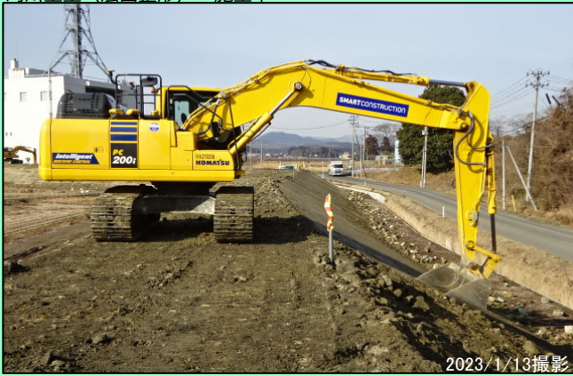
① 周囲堤部 河川土工（法面整形） 施工中
