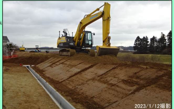
桧木川原地区 根固め工（根固めブロック据付） 施工中
