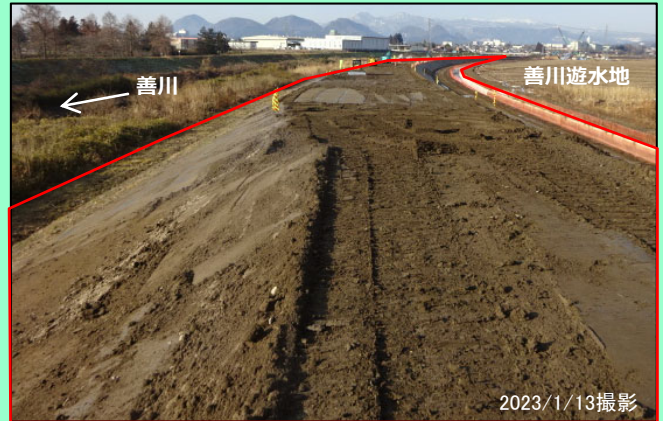
圍繞堤部 河川土工（法面整形） 施工中
