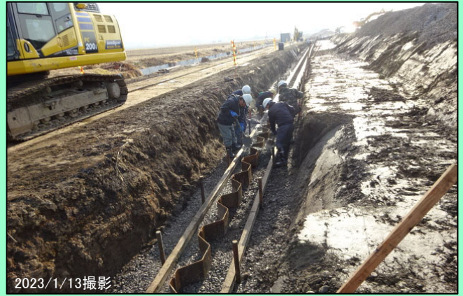
越流堤部（川表） 越流堤本体工（裏込砕石敷設） 施工中
