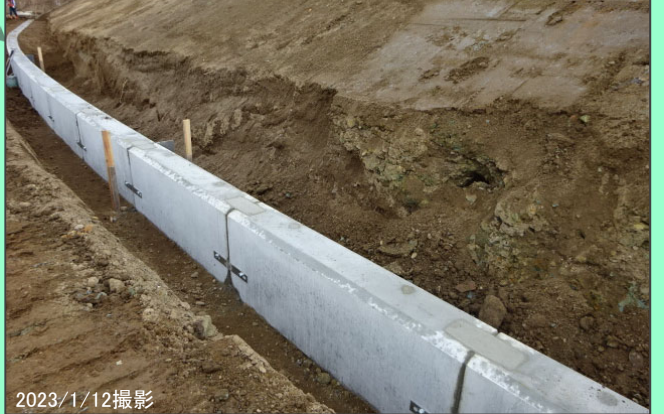
落合舞野地区 法覆護岸工（プレキャスト基礎） 施工中
