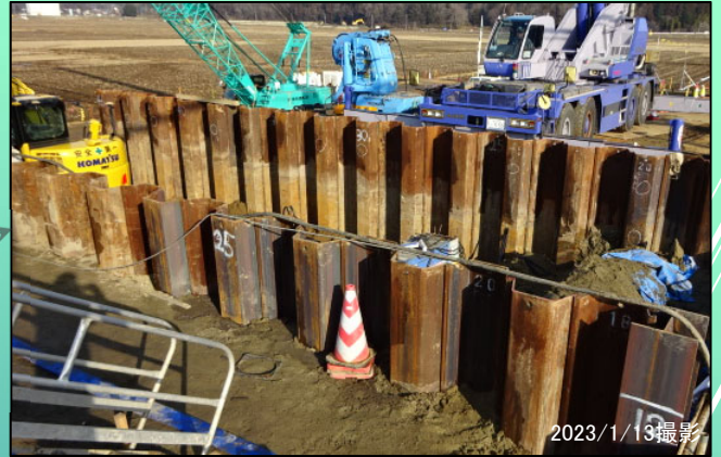
圍繞堤部 横断工（鋼矢板圧入：現場溶接継ぎ手） 施工中
