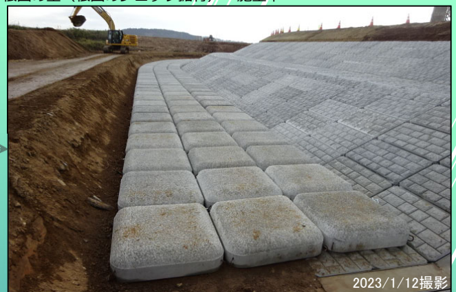
桧木川原地区 法覆護岸工（大型連結ブロック据付） 施工中
