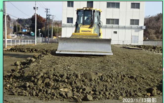
NTT大衡交換所 河川土工（築堤盛土） 施工中
