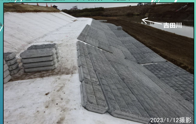
桧木川原地区 法覆護岸工（大型連結ブロック据付） 施工中
