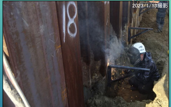
圍繞堤部 横断工（鋼矢板圧入：現場溶接継ぎ手） 施工中
