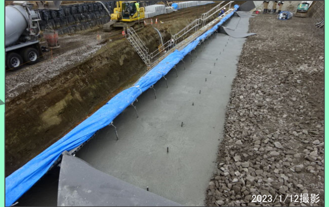
落合舞野地区 法覆護岸工（プレキャスト基礎） 施工中
