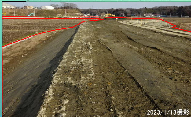
全景写真（奥田川排水樋門側：起点側）
