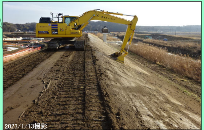
NTT大衡交換所 河川土工（築堤盛土） 施工中
