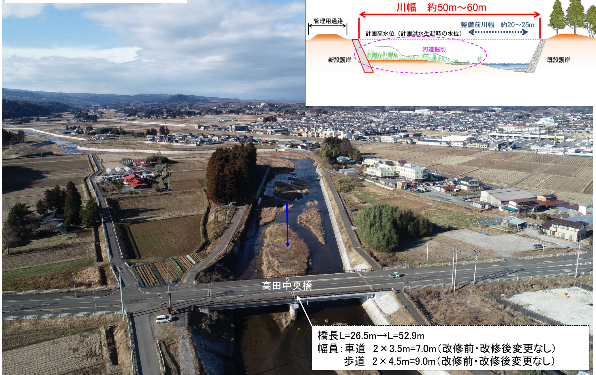
高田中央橋から上流側(整備後)
