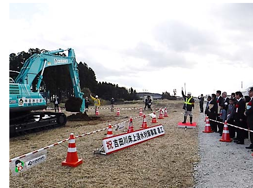
▲工事着工号令の様子
