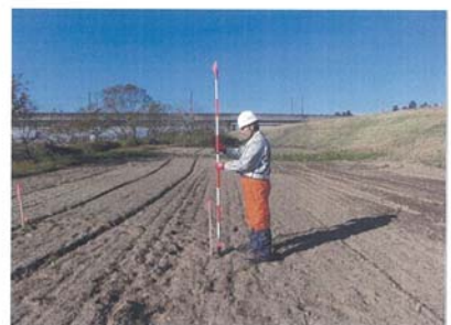
遠景 K642 プラスチック杭
