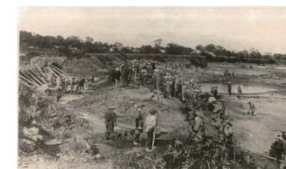
写真 2-2 明治43年8月洪水 鳴瀬川旧三本木 （大崎市）にて堤防決壊箇所を修復する様子
