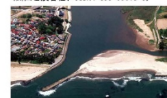
被災前河口部付近の状況
