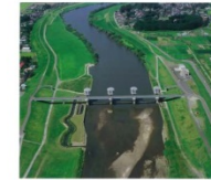
鳴瀬川中流堰
