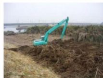
写真 5-19 塵芥処理の状況
