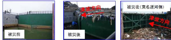
水門管理用水位計における河川津波高、不明 水門管理用水位計における河川位相高、T.P.7.6m 被災前後の水位の相違距離、約4m ゲート操作状況、不明(遠隔操作)
