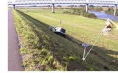
写真 5-10 堤防除草の状況(鳴瀬川)
