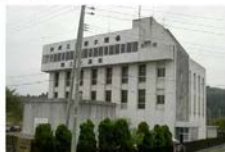
写真 3-13 鈴根五郎排水機場(昭和 55 年完成)
