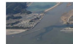
被災後河口部付近の状況
