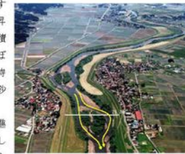
写真 3-14 鳴瀬川の低水路砂州の状況
