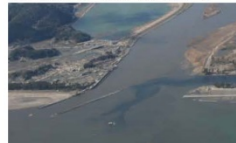
被災後河口部付近の状況
