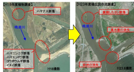
写真 3-34 地震後の河口部環境変化の状況
