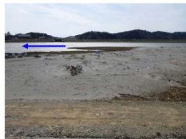
写真 3-35 河口部左岸高水敷の状況
