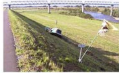
写真 5-9 堤防除草の状況(鳴瀬川)
