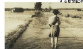
写真 2-3 昭和22年9月洪水 鳴瀬川旧三本木 （大崎市）奥州街道沿いの橋梁が水没
