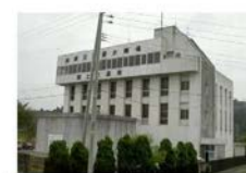
写真 3-13 鈴根五郎排水機場(昭和 55 年完成)
