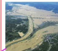
写真 2-1 昭和61年8月洪水 吉田川旧鹿島台（大崎市）の堤防決壊により浸水
