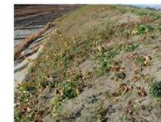
写真 3-12 イタドリ除草後の裸地化状況
