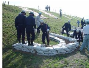
写真 5-37 水防工法訓練
