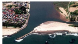
被災前河口部付近の状況
