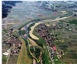
写真 3-14 鳴瀬川の低水路砂州の状況
