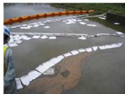
写真 3-20 善川油流出対策状況
