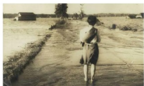
写真 2-3 昭和22年9月洪水 鳴瀬川旧三本木 （大崎市）奥州街道沿いの橋梁が水没
