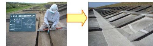
写真 5-18 高水護岸の補修状況
