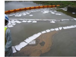
写真 3-19 善川油流出対策状況
