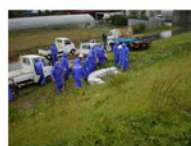
写真 3-8 漏水による水防活動の状況
