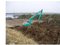
写真 5-20 塵芥処理の状況
