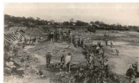
写真 2-2 明治43年8月洪水 鳴瀬川旧三本木 （大崎市）にて堤防決壊箇所を修復する様子
