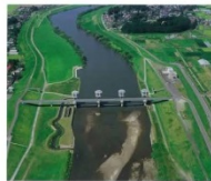
鳴瀬川中流堰
