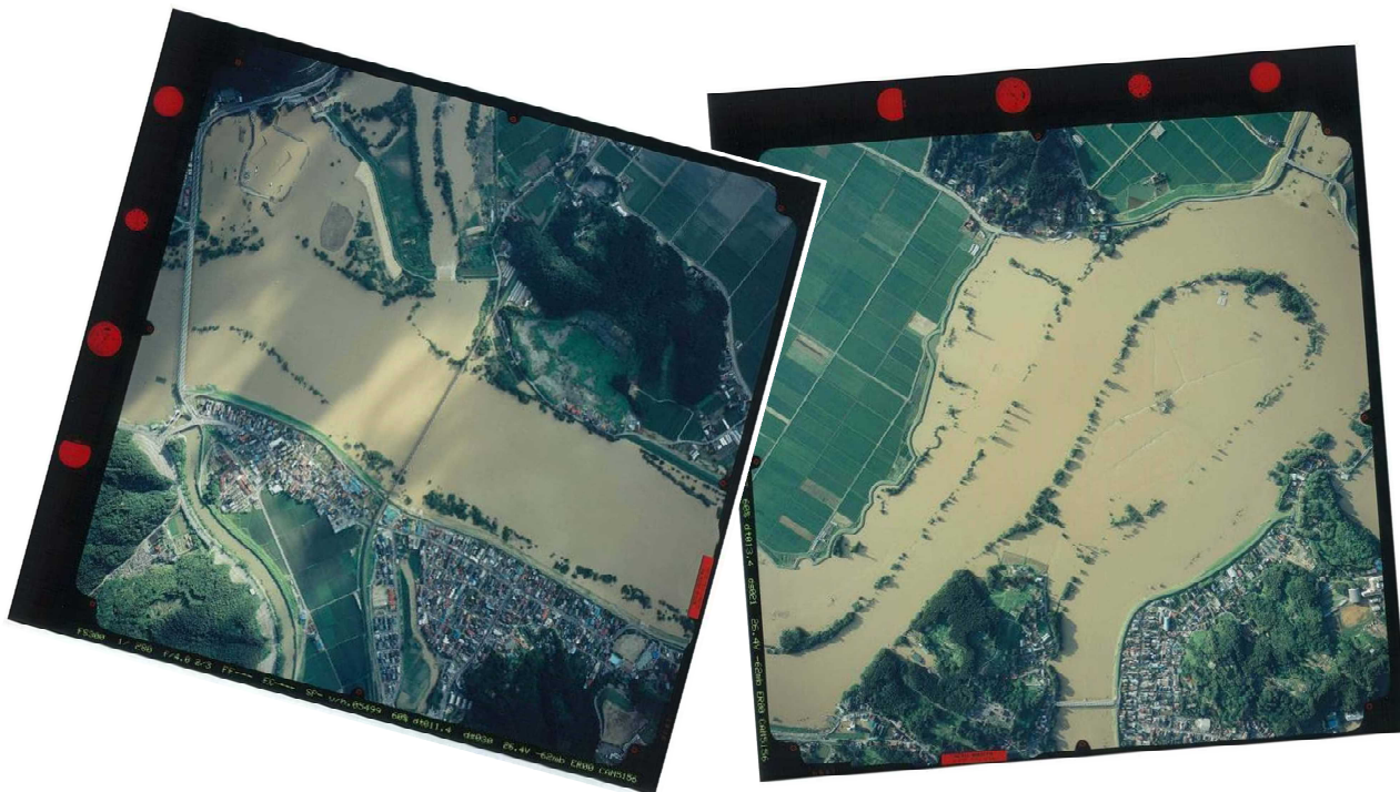
平成 14 年 7 月洪水(台風 6 号)航空写真(写真左:北上川 26k 付近、写真右:北上川 40k 付近)
