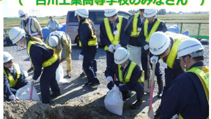
【河川維持工事(土のうづくり)】
