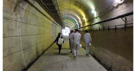
【鳴子ダム(内部見学)】
