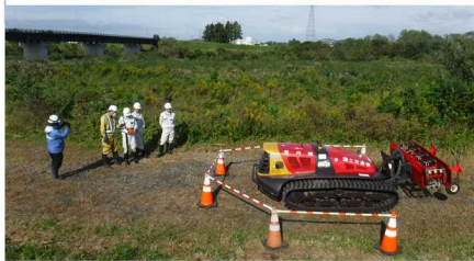
【河川維持工事(遠隔除草機械)】
