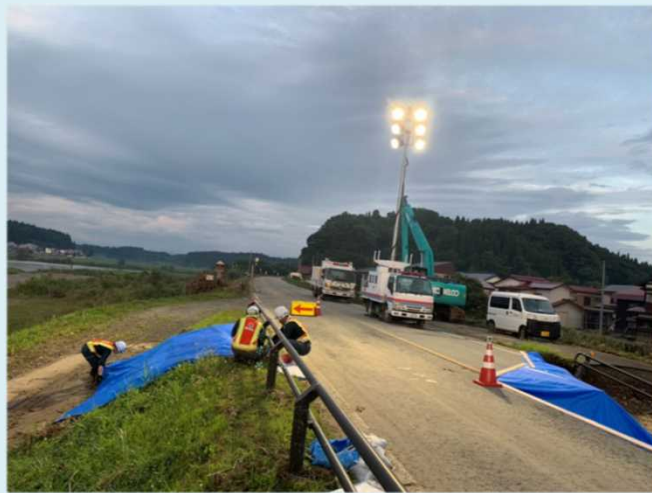
▲ 道路復旧現場で24時間体制復旧活動支援のため照明車で照明作業を実施。 場所：山形県最上郡戸沢村蔵岡地内
