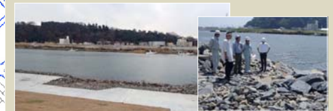
石の位置等を微調整して仕上げ
