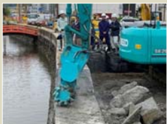
既存護岸を残すために、工夫しながら施工
