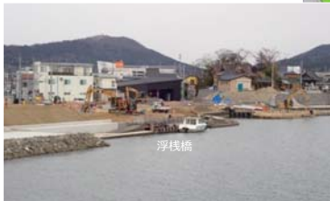
下流側にある「浮棧橋」を残す形で堤防を整備。浮棧橋を補修し、引き続き活用できるようにした。
