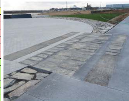
※ 河川工事より出てきた「井内石」を 祈りの場 沓脱石、小端積(河岸)等で再利用。
