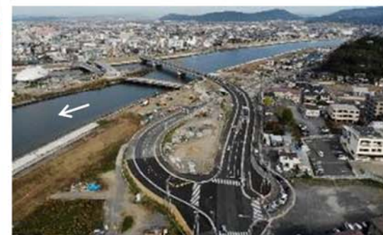
全景(左岸 下流側より) (R2.10.28撮影)
