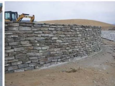
※ 河川工事より出てきた「井内石」を 祈りの場 沓脱石、小端積(河岸)等で再利用。
