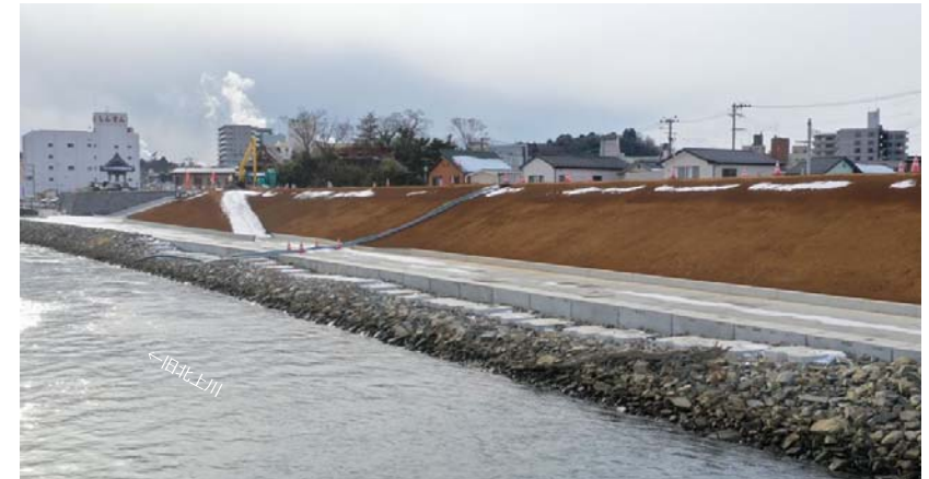
下流側飛石区間の施工状況 (R3.1)
