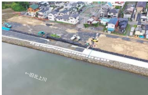
下流側飛石区間の施工状況（航空写真）
