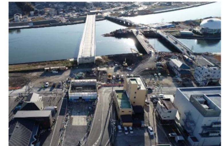
全景(西内海橋右岸側より) (R1.12.12撮影)
