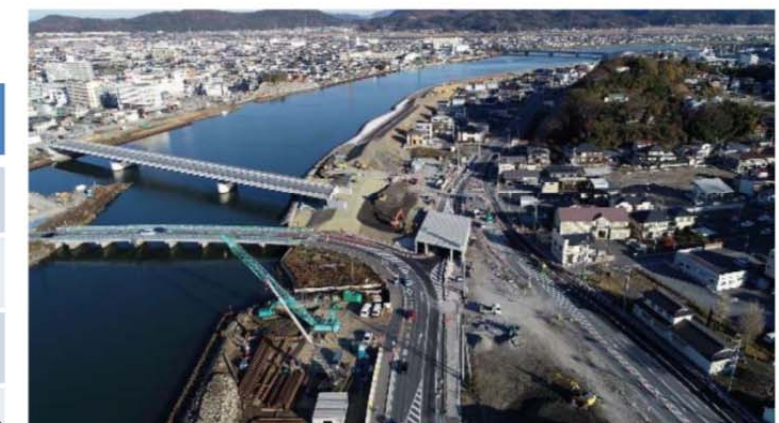
全景(内海橋左岸下流側より) (R1.12.12撮影)
