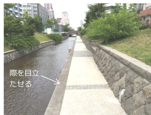
参考事例：創成川（札幌市）
