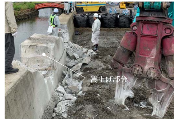
現在の大島神社前の石積み護岸
