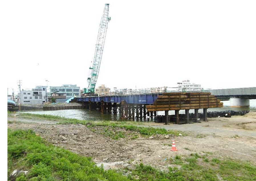
中瀬より、(仮)新西内海橋仮設橋状況 (H30.7.10 撮影)
