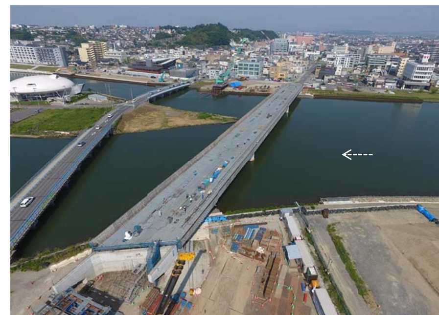
左岸側上空より、内海橋上部工施工状況 (H30.5.31 撮影)
