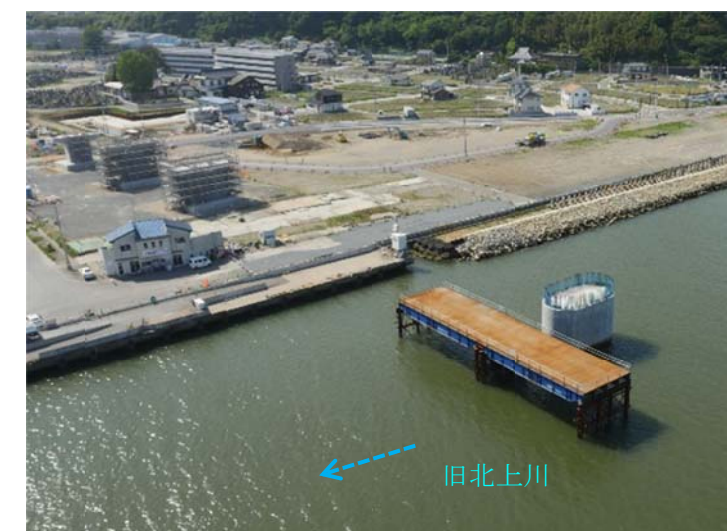
P4 橋脚上空から下部工状況 H30.6.7
