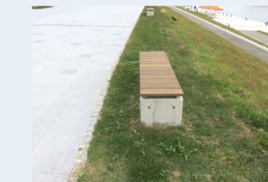
川側に設置したベンチ
