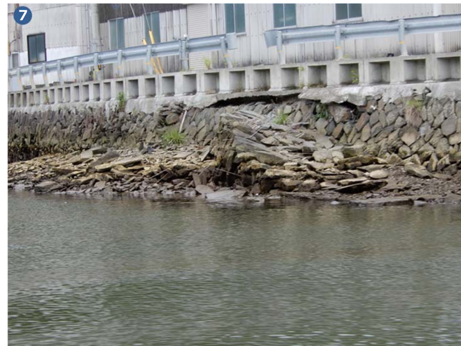
現存する「かわど」(川側より)
