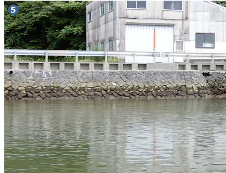
現況の石積み護岸
