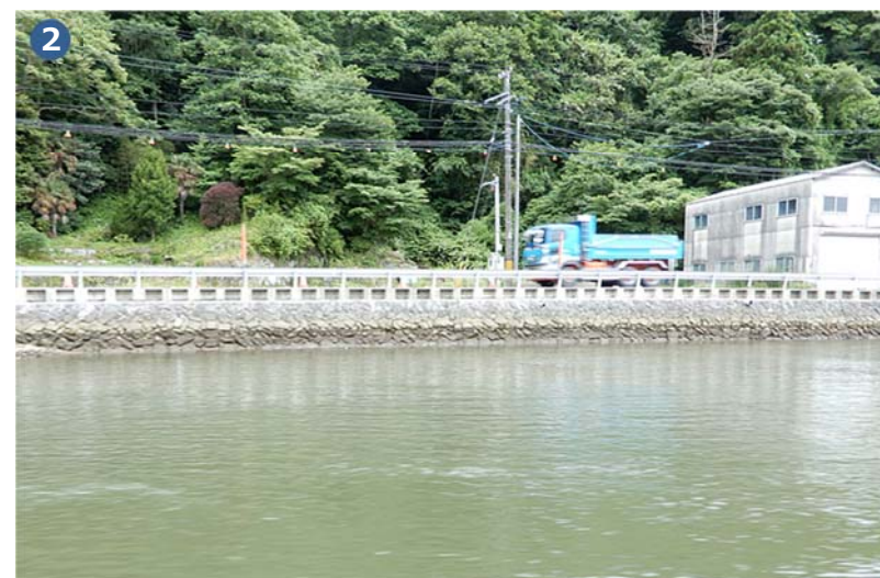
現況の石積み護岸
