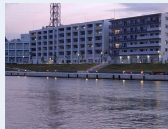
内海橋から見た状況
