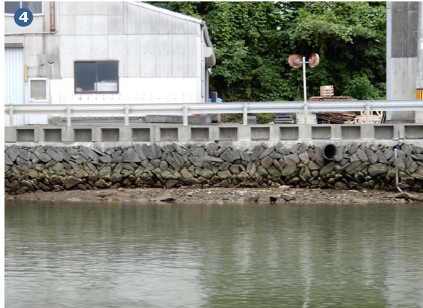
現況の石積み護岸
