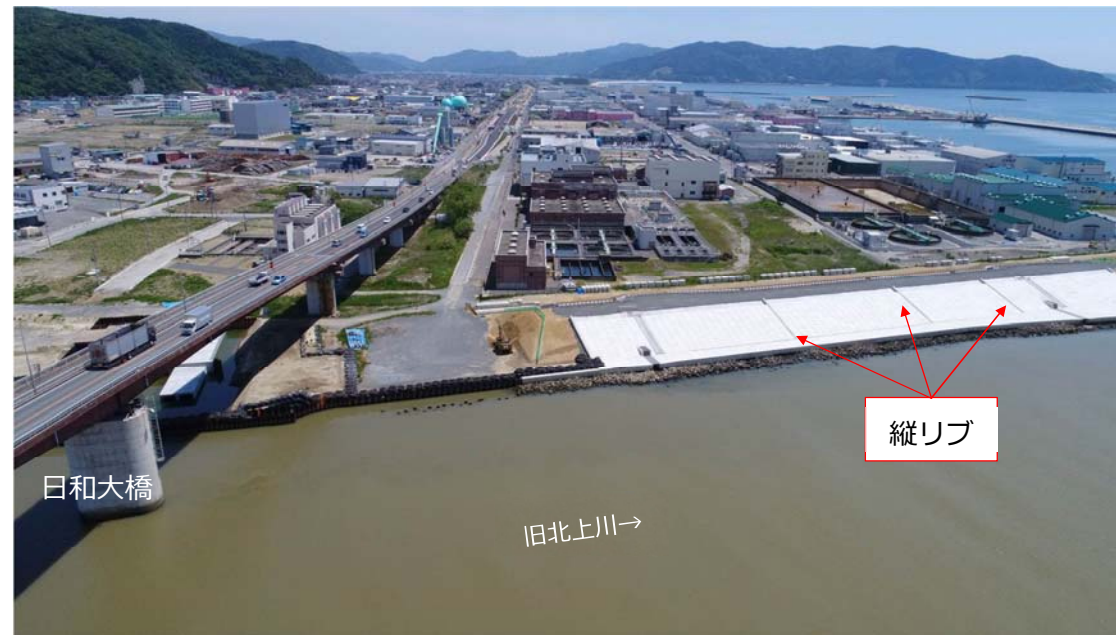
◎左岸河口部（既施工区間）堤防表面の縦リブ
