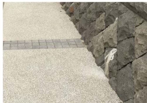
洗出し仕上げイメージ
