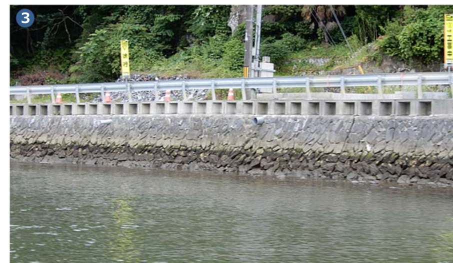
現況の石積み護岸
