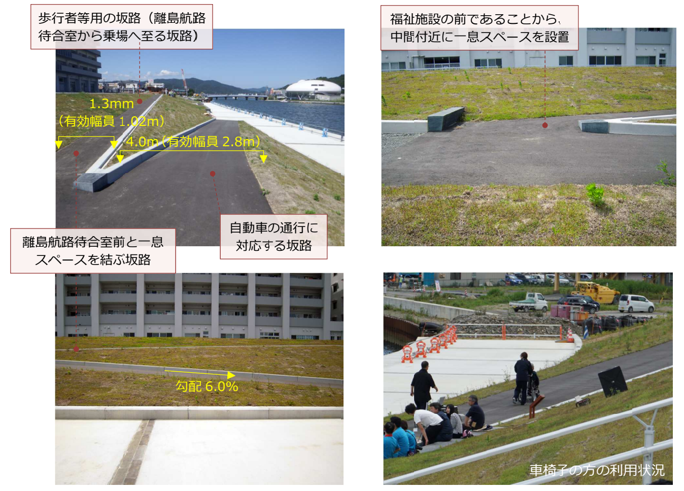
中央2丁目14・15番地区の施工状況
