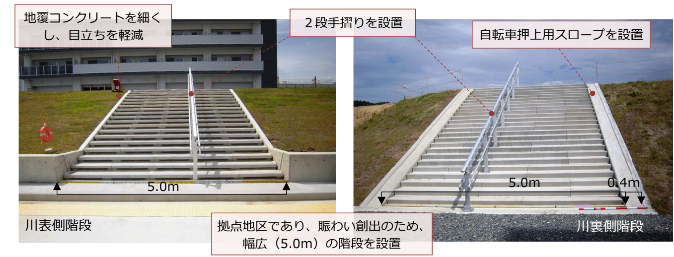
中央2丁目14・15番地区の施工状況
