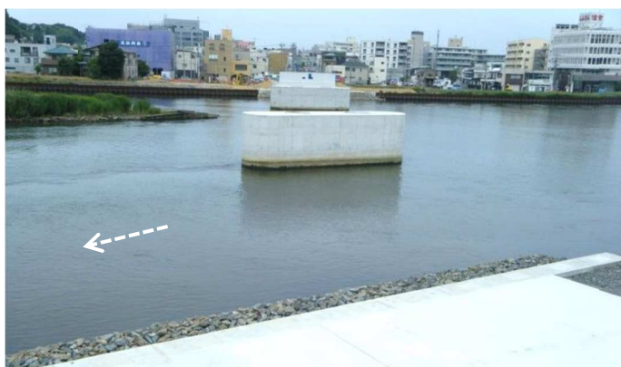
下部工完成(A2 橋台より) H29.6.28
