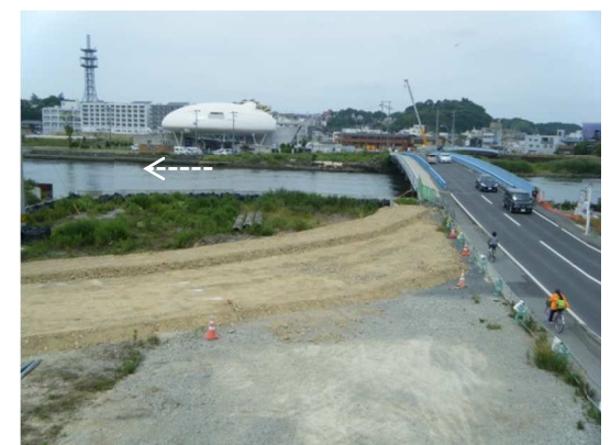
左岸側仮設道路施工状況 H29.6.28
