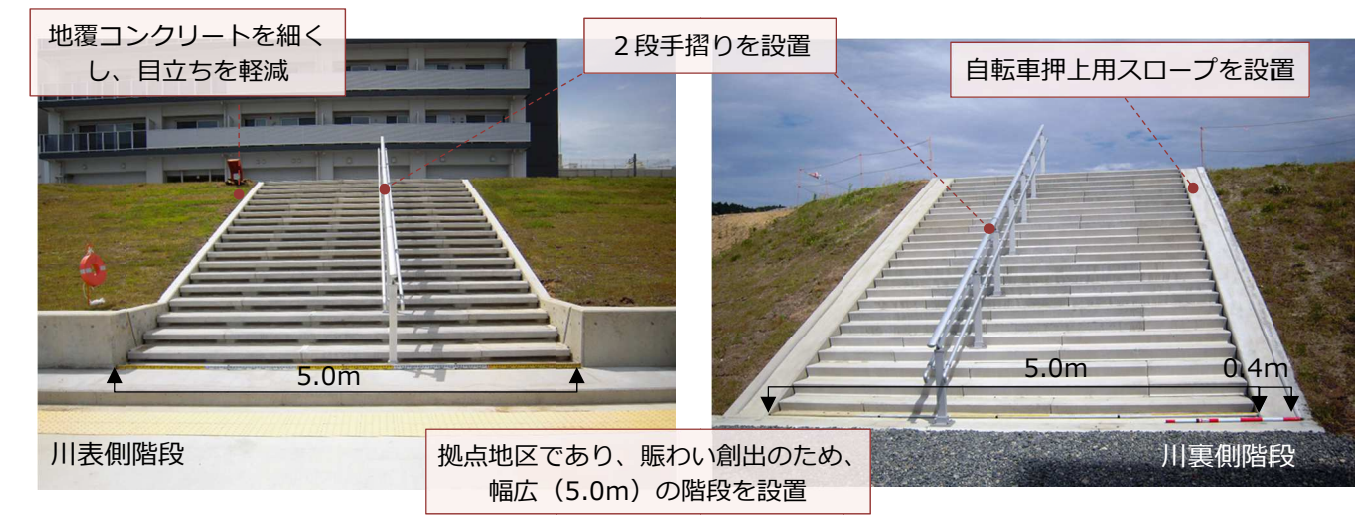
中央2丁目14・15番地区の施工状況
