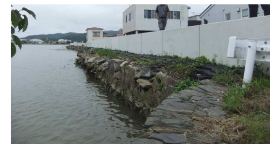
八幡町の護岸 (2013年)
