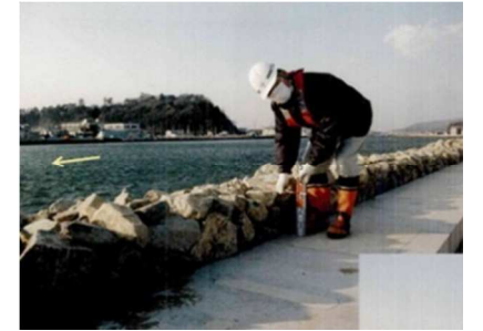
修景用捨石の試験施工
