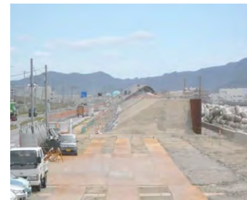
《現状》 その2工事からその1工事を望む
