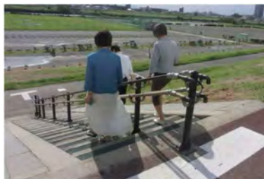
中間部に両側2段(高さ65cm、85cm)の手摺を設置
