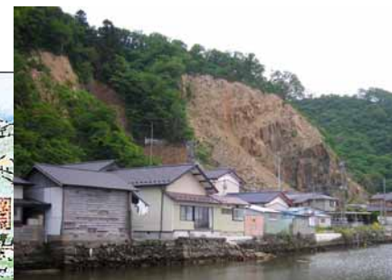
井内地区の石切り場
