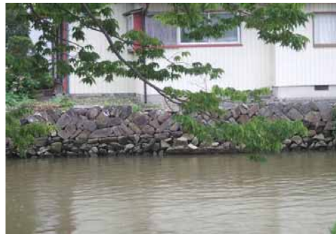
左岸井内付近の石積み
