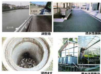
雨水貯留浸透施設の実例
