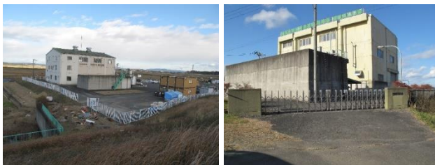
志田谷地排水機場
