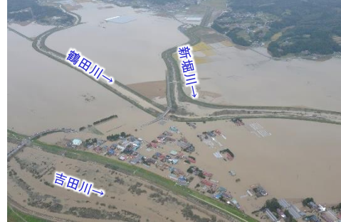
大崎市志田谷地地区付近の浸水状況
