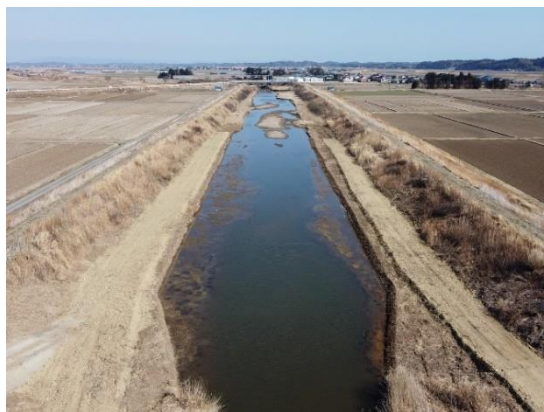
堆積土砂の撤去（鶴田川）
