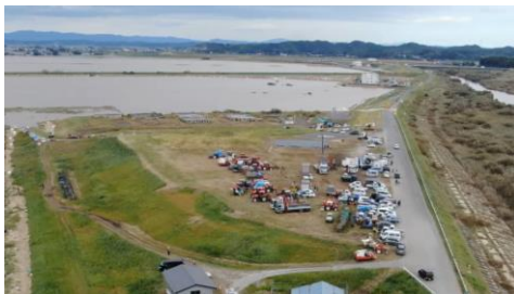
水防拠点の整備
