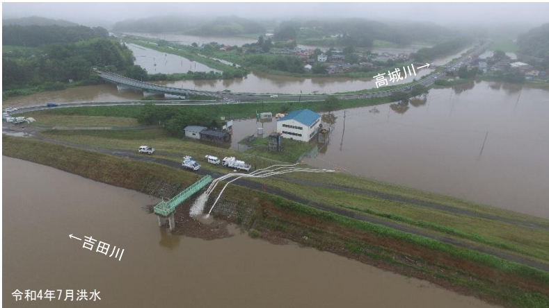
排水ポンプ車による排水活動
