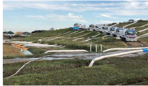
令和元年東日本台風における排水ポンプ車による排水作業の様子
