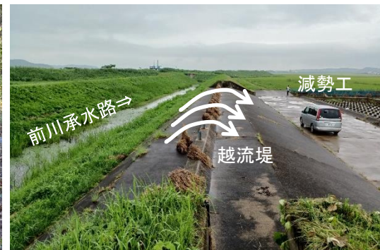
前川承水路右岸 農地貯留 (大郷町中粕川地区)
