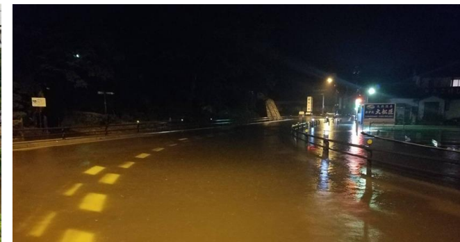
国道45号の冠水状況(松島海岸)
