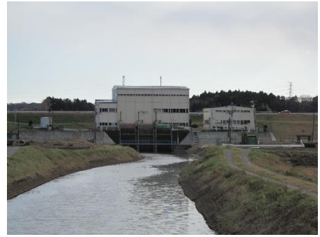
品井沼排水機場
