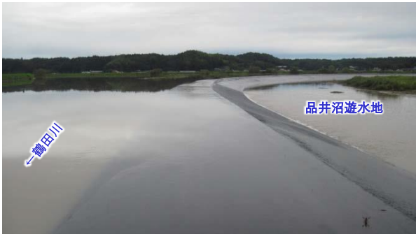
品井沼遊水地への流入状況
