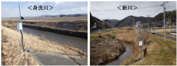
簡易型河川監視カメラ整備状況
