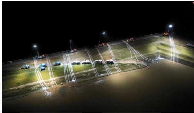
令和元年東日本台風における排水ポンプ車による排水作業の様子
