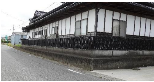
宅地嵩上げ例（大崎市志田谷地地区）
