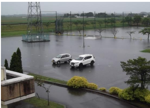
流域内の内水調節池・防災調整池
