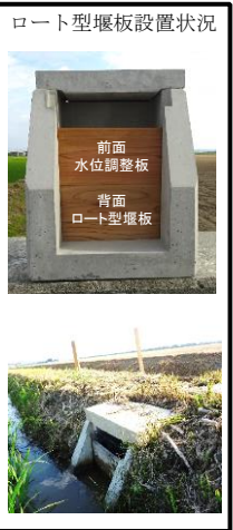
ロード型堰板設置状況
