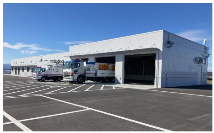
志田谷地防災センター
