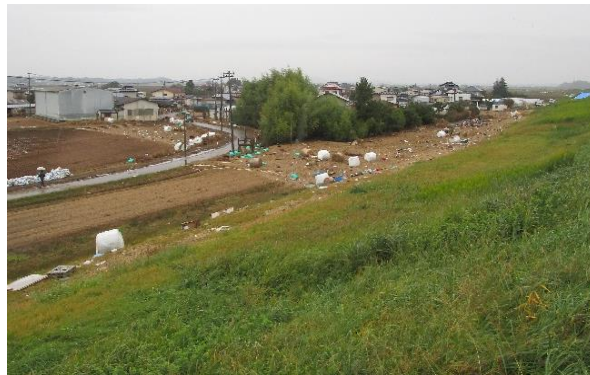
洪水後に散乱する稲わらやゴミ (令和元年東日本台風)
