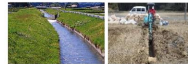
農業用排水施設の整備
