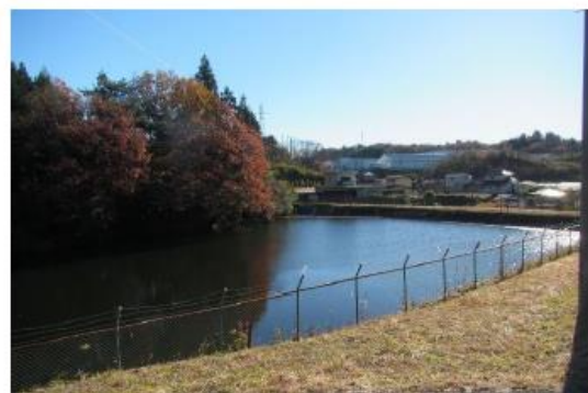
農業用ため池
