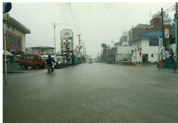
高城川右岸堤内地の浸水状況
