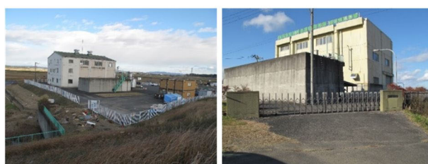
志田谷地排水機場
