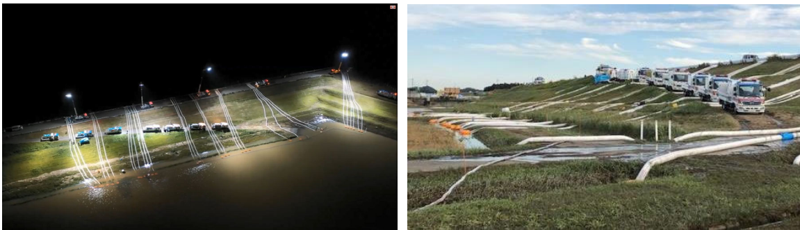
令和元年東日本台風における排水ポンプ車による排水作業の様子
