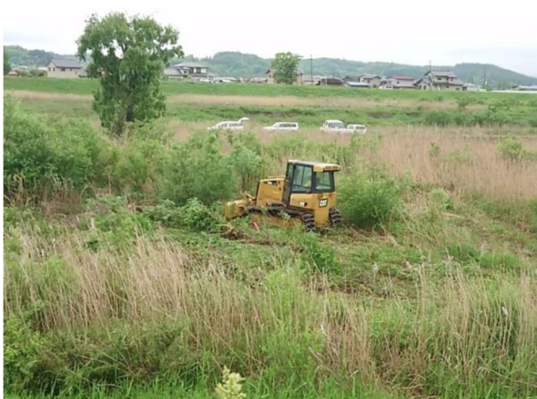
樹木再再繁茂対策事例 （ブルドーザーによる樹木踏みつぶし）
