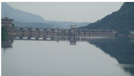
南川ダム（かんがい期）
