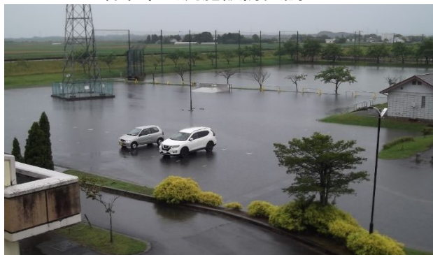
流域内の内水調節池・防災調整池
