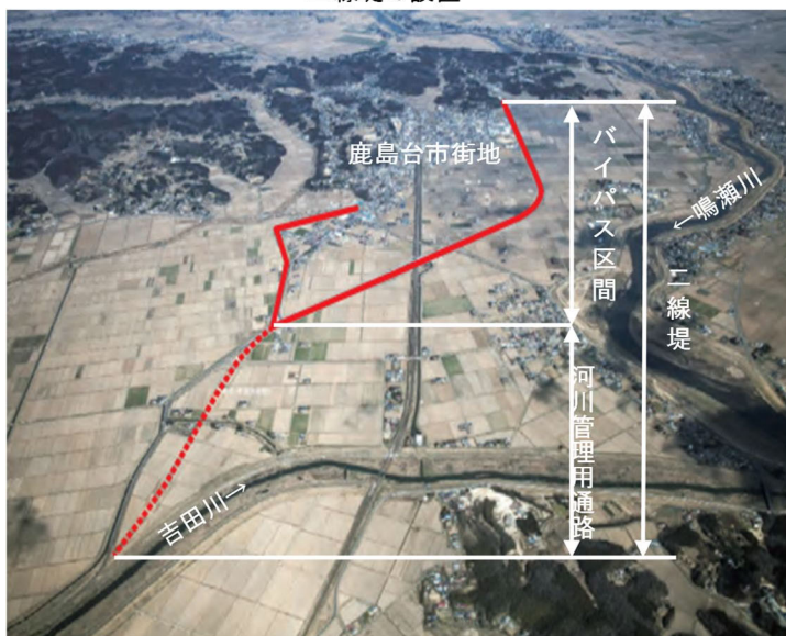
二線堤の設置
