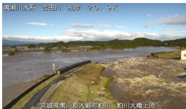
堤防決壊地点（大郷町中粕川地区）
