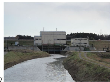
品井沼排水機場
