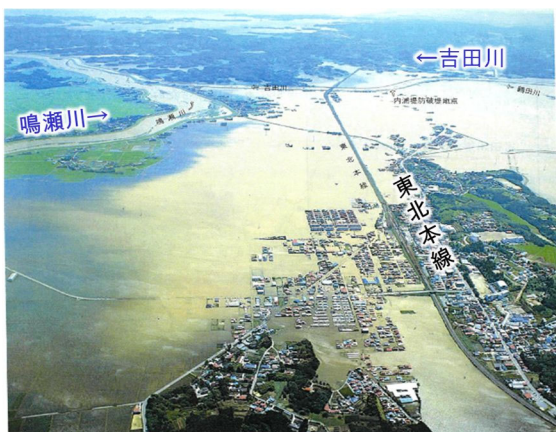
大崎市（鹿島台）市街地の浸水状況
