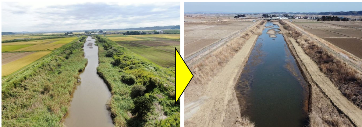
堆積土砂の撤去（高城川水系鶴田川）
