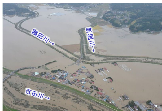
大崎市志田谷地地区付近の浸水状況
