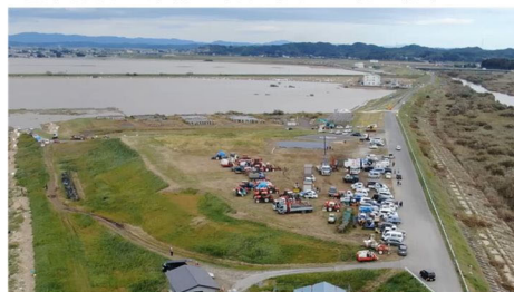
水防拠点の整備
