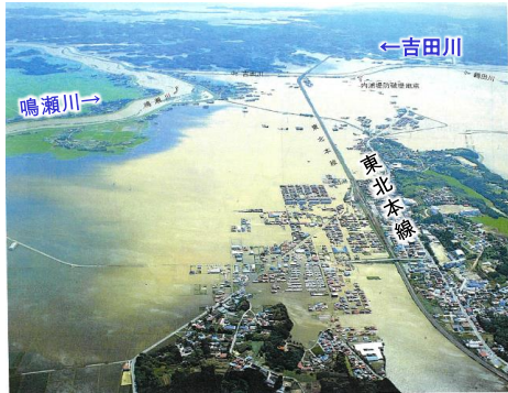
大崎市(鹿島台)市街地の浸水状況
