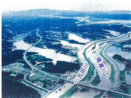
吉田川下流部の浸水状況
