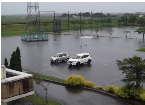
流域内の内水調節池・防災調整池
