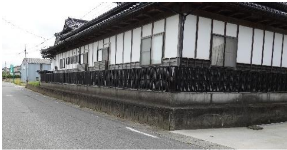
宅地嵩上げ例（大崎市志田谷地地区）
