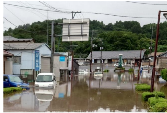
JR松島駅周辺の内水浸水状況(令和4年7月洪水)
