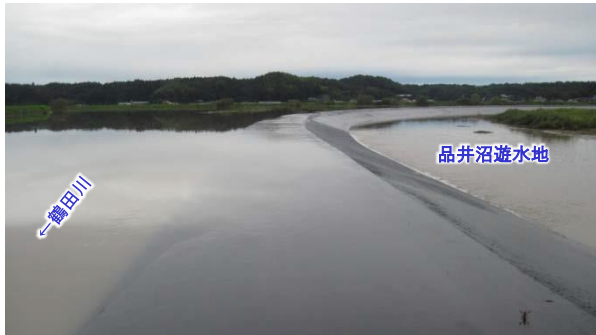
品井沼遊水地への流入状況
