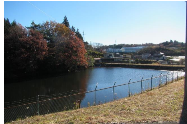
農業用ため池
