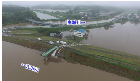
幡谷サイフォン付近の浸水状況
