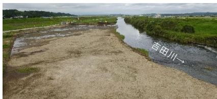
河道掘削（品井沼大橋上流）
