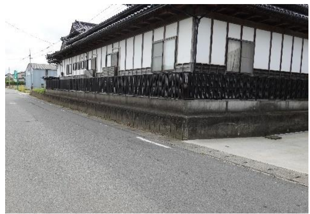
宅地嵩上げ例 (大崎市志田谷地地区)
