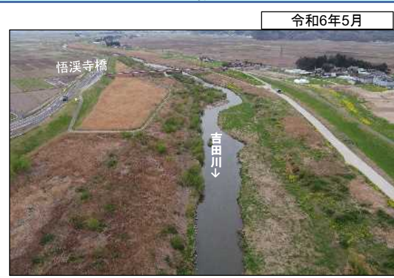
②【吉田川】大和町(悟溪寺橋付近)における河道掘削後の状況
