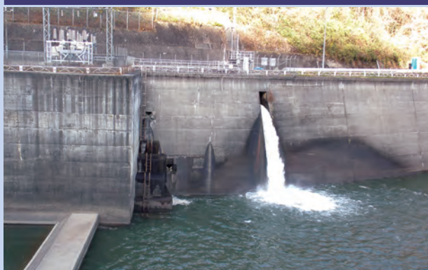
釜房ダム管理用発電設備（施工前）
