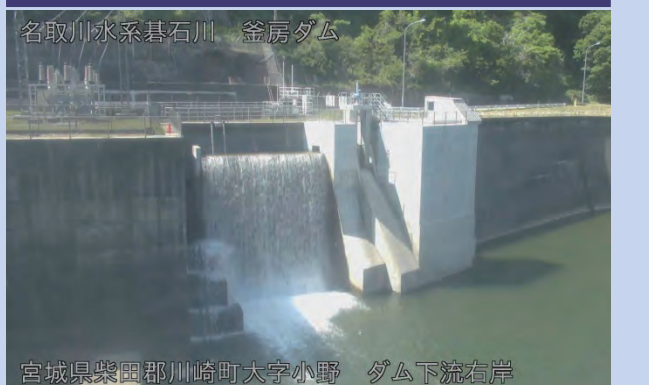
釜房ダム管理用発電設備（施工後）
