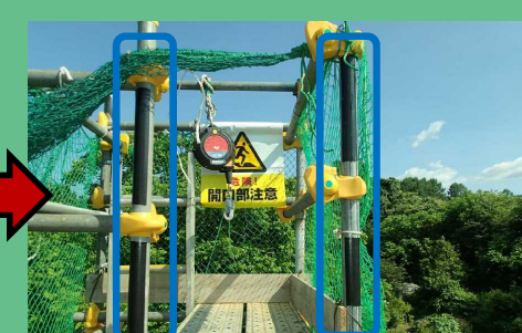
滑り止めテープを貼付
