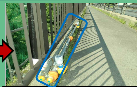
点滅灯を設置
