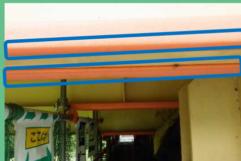
頭上付近の桁の端部等がスポンジで養生されている
