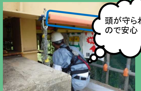
頭上付近の桁の端部等がスポンジで養生されている
