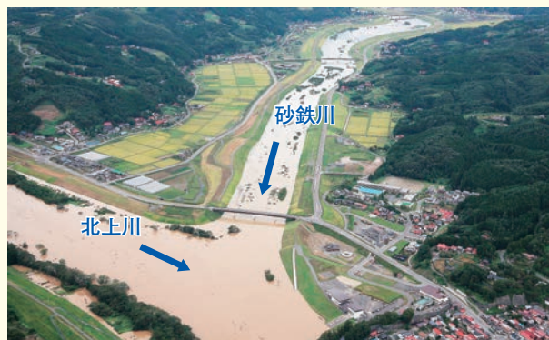
平成19年9月洪水の状況（堤防整備後）
