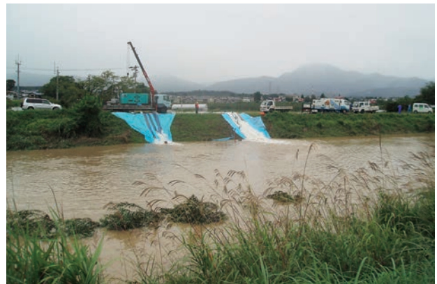
排水ポンプ車による内水排除（紫波町高水寺地区）
