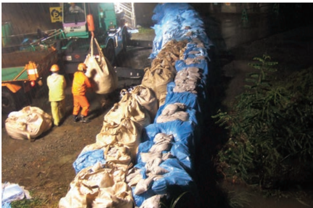
栗石川左岸の無堤部における水防活動（盛岡市駅前通地区）
