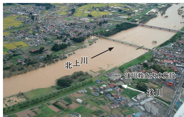
後川地区救急内水施設（平成19年9月18日）
