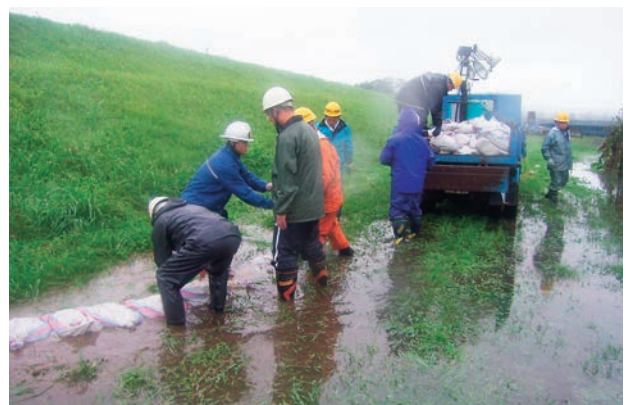
堤防漏水対策のための水防活動（奥州市江刺区岩谷堂）
