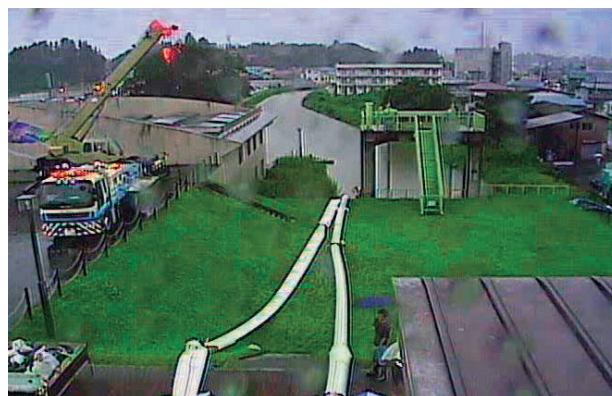
排水ポンプ車による排水作業状況（後川地区救急内水施設）
