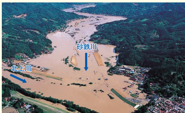
平成14年7月洪水の状況（堤防整備前）
