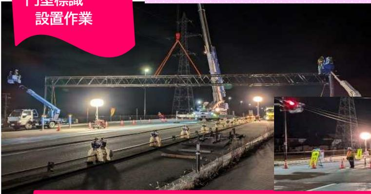
去る12月5日午前0時から5時の時間帯において、大型門型標識設置作業を行うため、西大橋を含む近接区間の全面通行止めを行いました。
